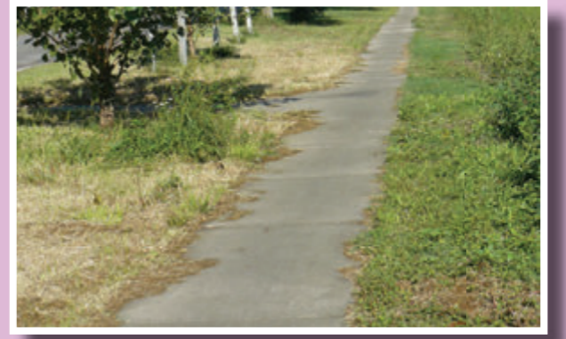
Járdák felújítása, építése
