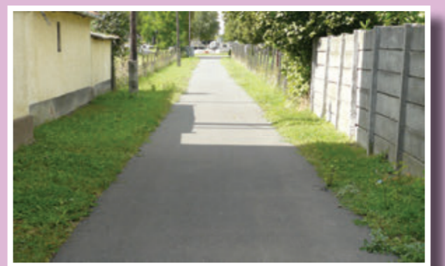
Római Katolikus Temető útépitése
