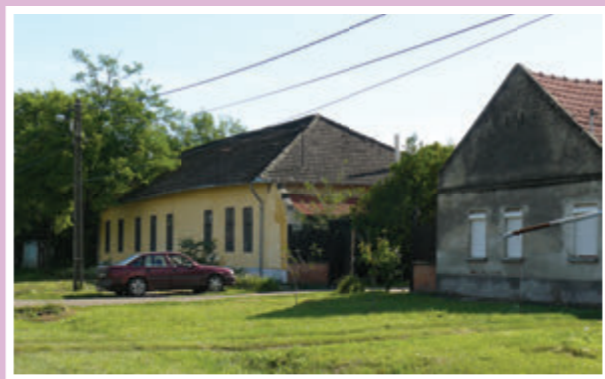
Úttörő u. 4. felújítása
