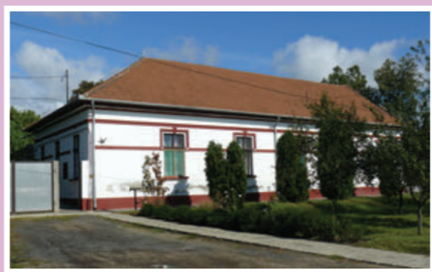
II. sz. Óvoda felújítása
