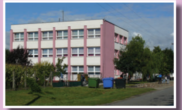
Márki Sándor Ált. Isk. felújítása
